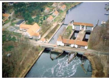
Ansicht der heutigen Schleusenanlage. Das Gebäude auf der linken Seite ist das nach dem Abriss des Schleusengehöfts errichtete Großwirtshaus „Schleusenkrug“. Nach Umbau wurde daraus am 1. Sept. 1958 eine Berufsbildungseinrichtung. Heute ist es ein Berufsbildungszentrum der WSV des Bundes.
