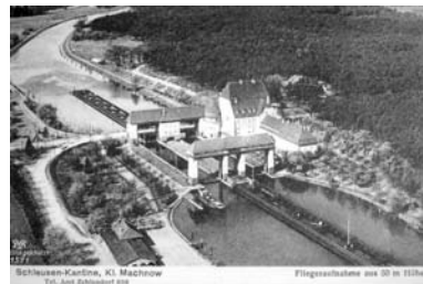
Die architektonisch gelungene Doppel-Schleusenanlage Kleinmachnow mit Bootschleppe. Die Gestaltung sollte nach dem Wunsch der Erbauer ein „großes Kulturgut“ darstellen und auch eine Attraktion für die Bevölkerung bilden.
