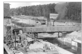
Baustelle der Nordkammer, die 1941 fertiggestellt wurde.
