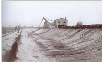
Bagger beim Bodenaushub zur Herstellung des Kanalprofils bei Tempelhof im Jahr 1904.
