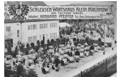
Das vom Kreis Teltow erbaute alte „Schleusen-Wirtshaus“. Viele Besucher schauten von dort den Schleusenvorgängen zu. Es musste 1939 der neuen Nordschleuse weichen.
